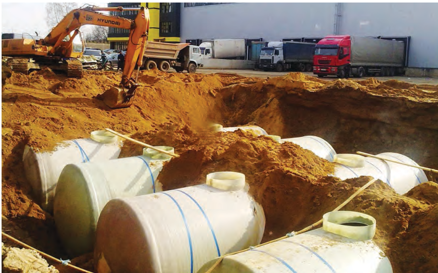
Рис. 2. Резервуары из стеклопластика
