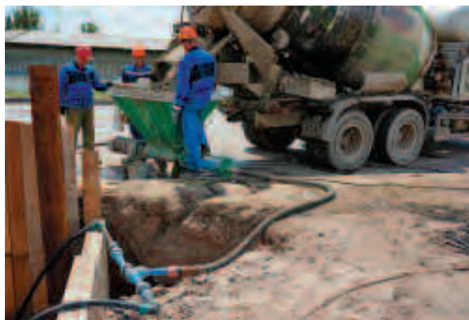
Рис. 5. Тампонирующее межтрубного пространства
