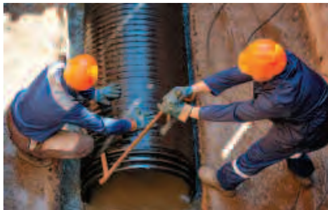
Рис. 4. Свинчивание резьбовых модулей
