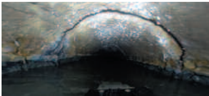
Рис. 1. Видеоинспекция самотечного трубопровода
